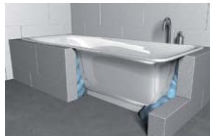
Заполнение полостей при монтаже ванн
