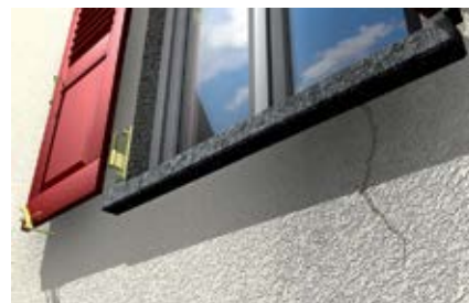
Заделка наружных трещин в кирпичной кладке
